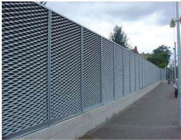
Exemple d'écrans acoustiques avec un bardage en métal déployé
