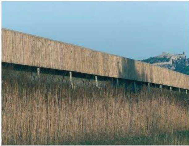
Exemple d'écrans acoustiques avec bardage bois dans un milieu naturel
