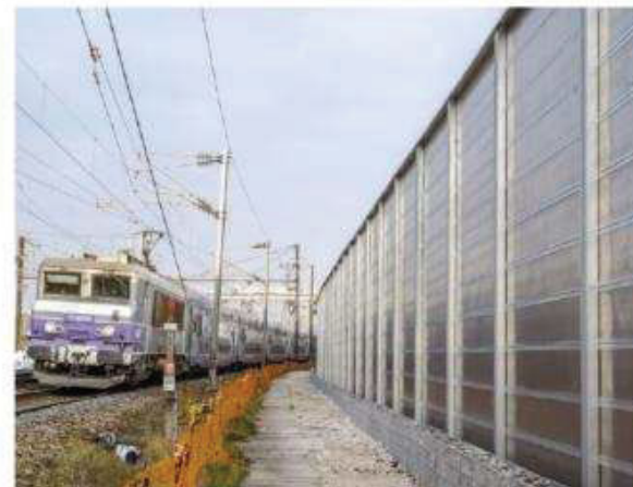
Aménagement d'un écran acoustique sur le domaine ferroviaire avec bardage bois (vue emprises ferroviaires) - Projet SNCF - Saint-Denis (93)
