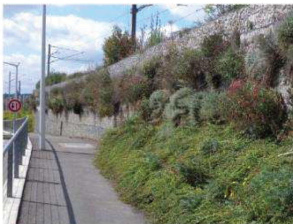
Aménagement et intégration d'un écran acoustique avec la mise en œuvre de gabions végétalisés - Projet SNCF - Moirans (38)
