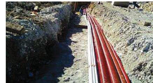
Enfouissement de réseau électrique (source : ville-chaville.fr)
