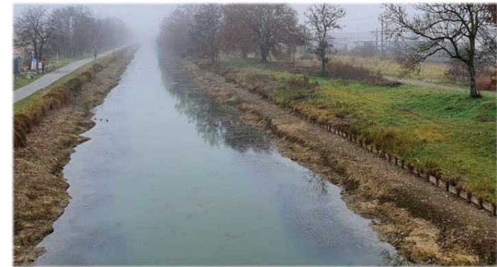
Exemple de risberme favorable à l'installation de fascines visible en période de chômage (source : SNCF)
