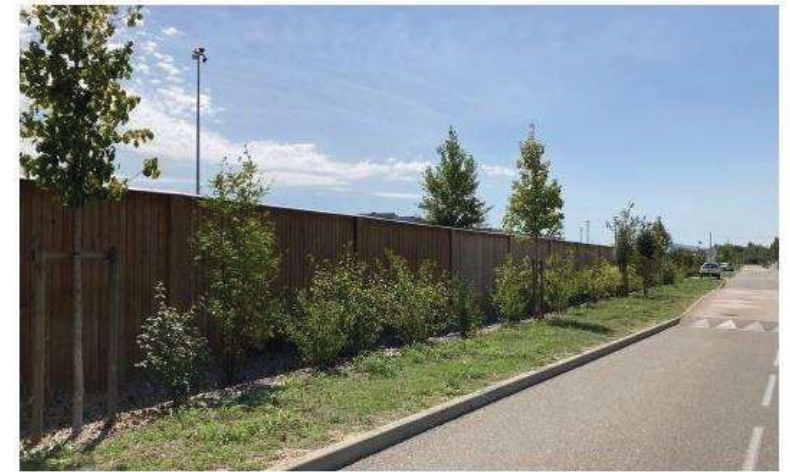
Exemple d'écrans acoustiques avec bardage bois - Projet SNCF - Porte-lès-Valence (26)
