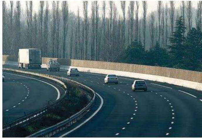
Exemple d'écrans acoustiques avec bardage bois le long d'une infrastructure routière
