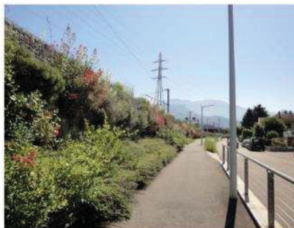
Aménagement et intégration d'un écran acoustique avec la mise en œuvre de gabions végétalisés - Projet SNCF - Moirans (38)
