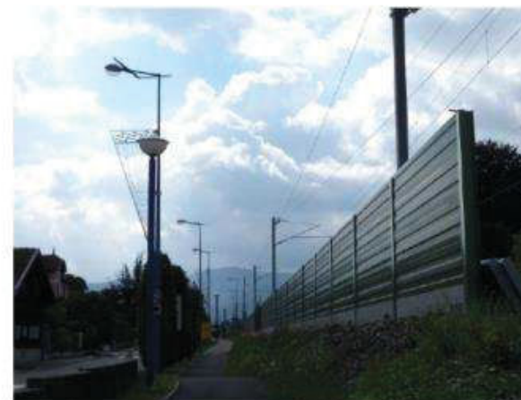
Aménagement et intégration d'un écran acoustique avec la mise en œuvre de gabions végétalisés - mur acoustique avant façade gabion
